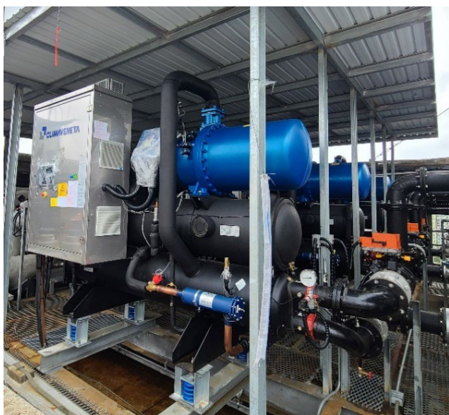
在荔枝角政府合署更换具备变速驱动器的水冷式制冷机
