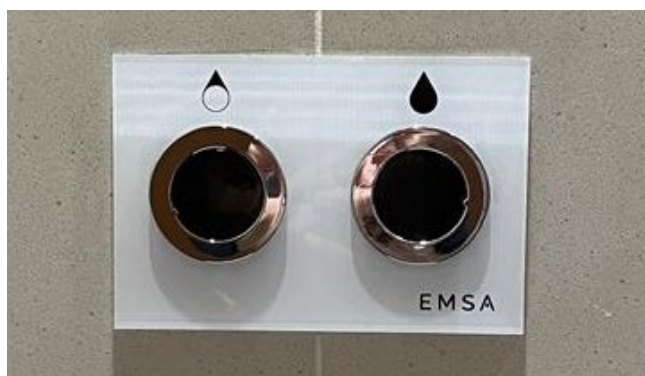
港珠澳大桥香港口岸的双掣式冲厕水箱
