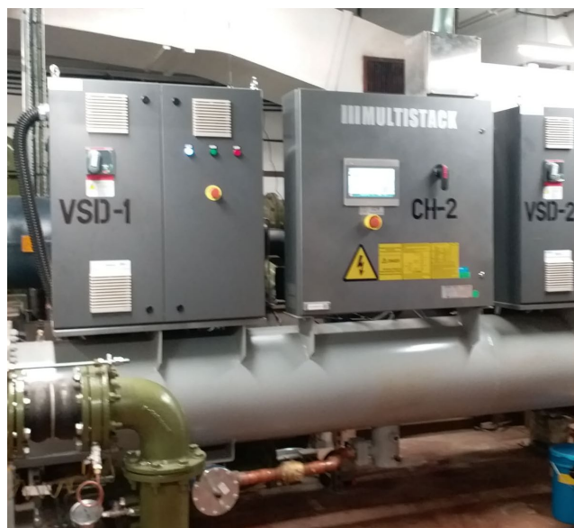
在九龙政府合署更换海水冷式制冷机
