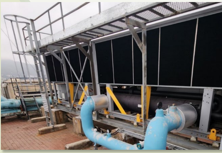
更换胡忠大厦的气冷式制冷机
