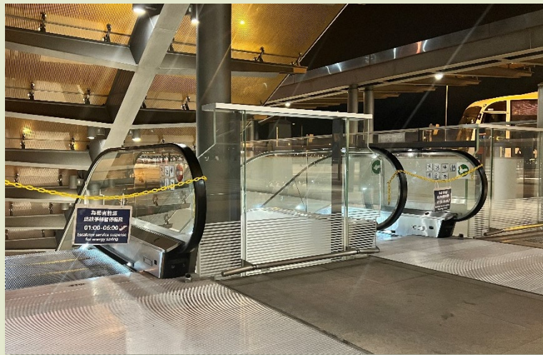
港珠澳大桥香港口岸善用自动梯的使用时间
