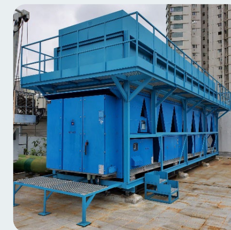
更换东区法院大楼的气冷式制冷机
