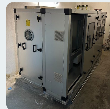
更换宏昌大厦的空气处理机组
