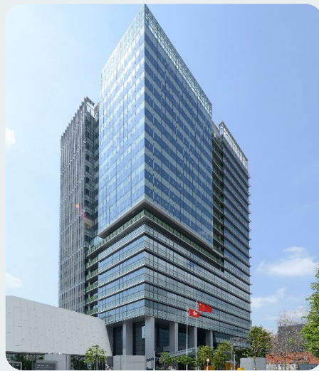
工业贸易大楼
