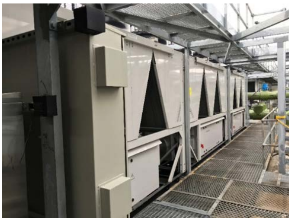
更換長沙灣政府合署大樓的製冷系統
