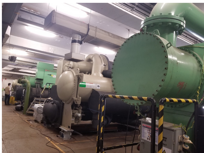
更換金鐘道政府合署海水水冷式製冷機
