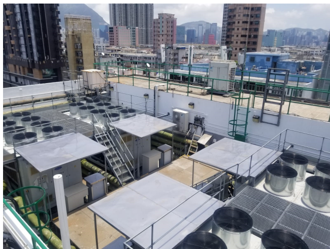
更換土瓜灣政府合署氣冷式製冷機及冷凍水泵
