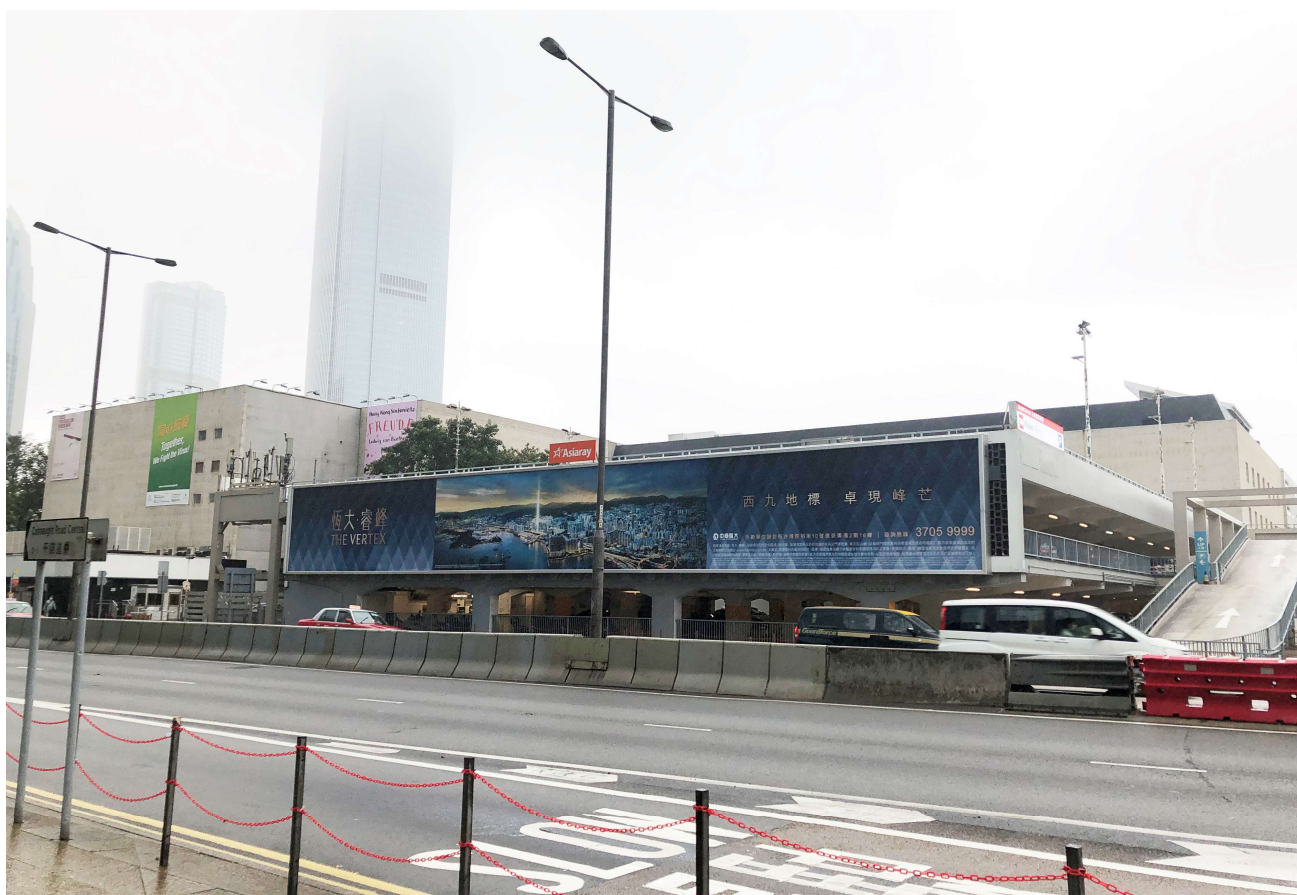
規定晚上十一時至上午七時關掉外牆的廣告招牌燈光裝置
