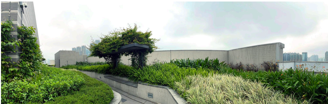
西九龍政府合署綠化屋頂
