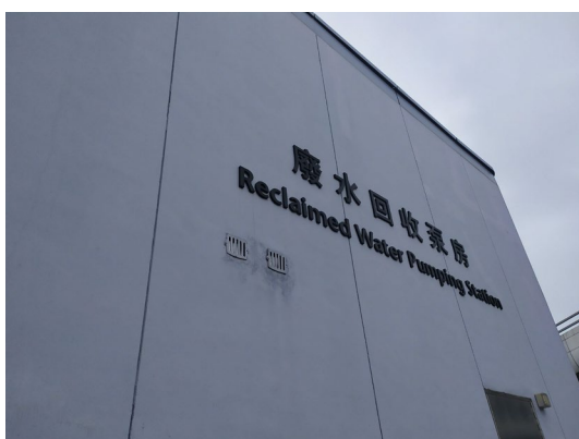
港珠澳大橋香港口岸的廢水回收泵房
