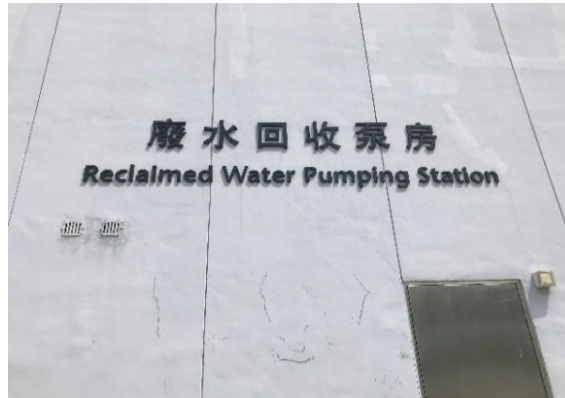
港珠澳大橋香港口岸的廢水回收泵房
