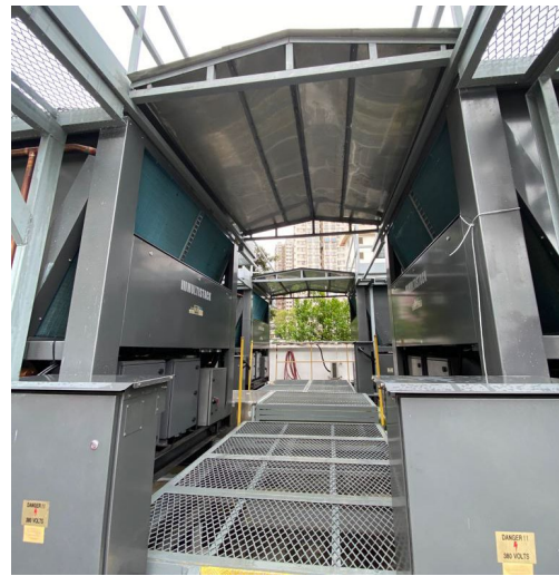
在大埔政府合署更換具備變速驅動節能器的氣冷式製冷機及冷凍水泵
