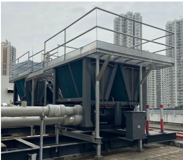
在大興政府合署更換具備變速驅動節能器的氣冷式製冷機
