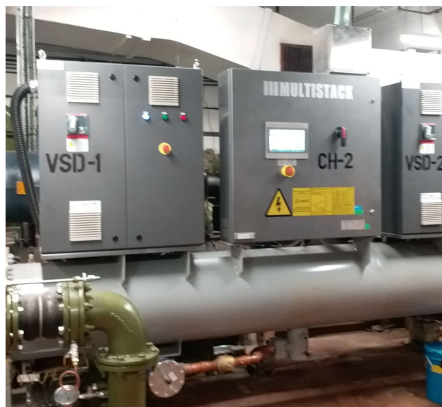
在九龍政府合署更換海水冷式製冷機
