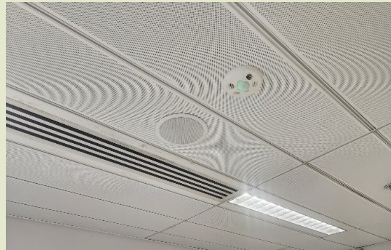
工業貿易大樓的控制照明感應器
