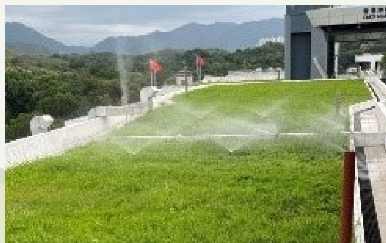
香園圍邊境管制站以雨水回收系統進行灌溉
