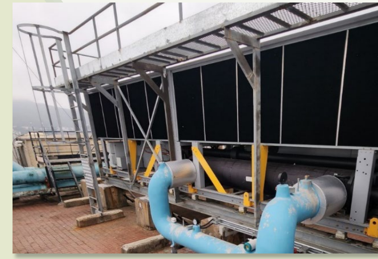
更換胡忠大廈的氣冷式製冷機
