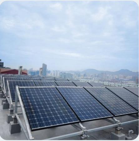
北角政府合署的太陽能光伏板系統
