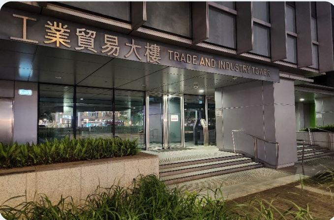
工業貿易大樓在非運作時間關掉戶外照明裝置
