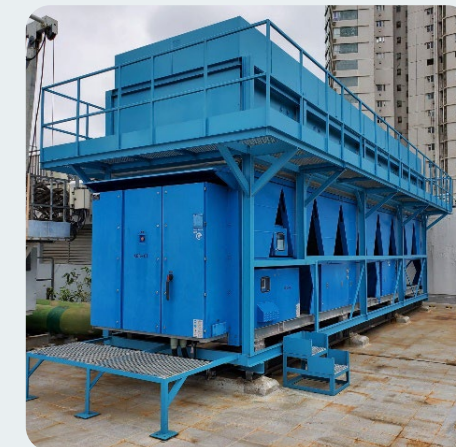
更換東區法院大樓的氣冷式製冷機
