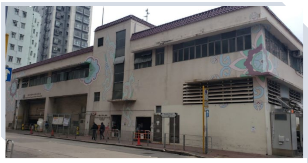
上海街及窩打老道交界處(前上海街臨時垃圾收集站、露宿者服務單位及上海街 / 窩打老道公廁)
