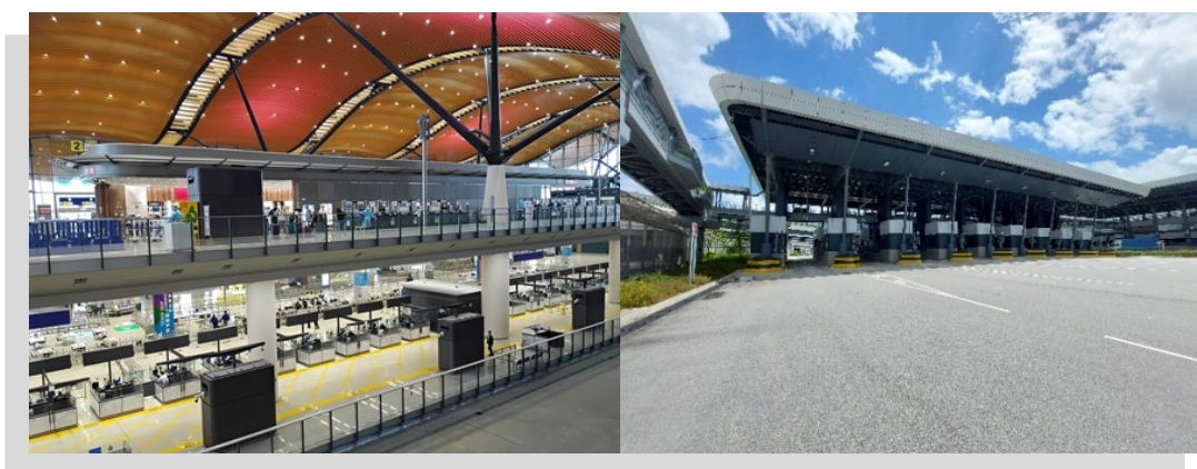
港珠澳大橋香港口岸旅檢大樓
