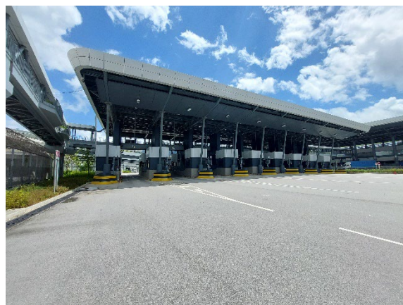
香園圍邊境管制站貨車檢查亭(入境)
